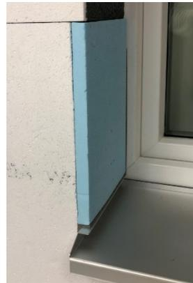
Die Verklebung des Passtückes erfolgt vollflächig, dünn-schichtig mit Dämmplattenkleber. Die Putzschichten an das Putzbord sind mit einem Trennschnitt zu entkoppeln.
