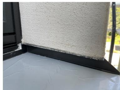
Die Höhe der hinteren Aufbugung muss rahmenseitig mindestens 15 mm betragen, damit eine Anschlussfuge mit elastischen Dichtstoffen oder Fugendichtungsbändern gemäss Norm SIA 274 ausgeführt werden kann.
